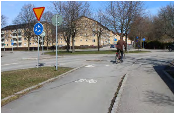
Figur 12. Bristfällig vägmålning. Ekebyvägen vid korsning med Krongatan.
